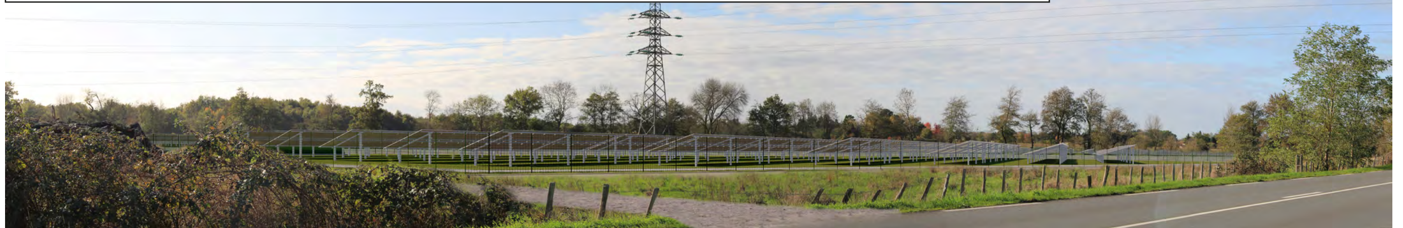
PM2 Photomontage du projet – Vue directe, légèrement en retrait, sur une partie du parc photovoltaïque et sur son chemin d'accès
