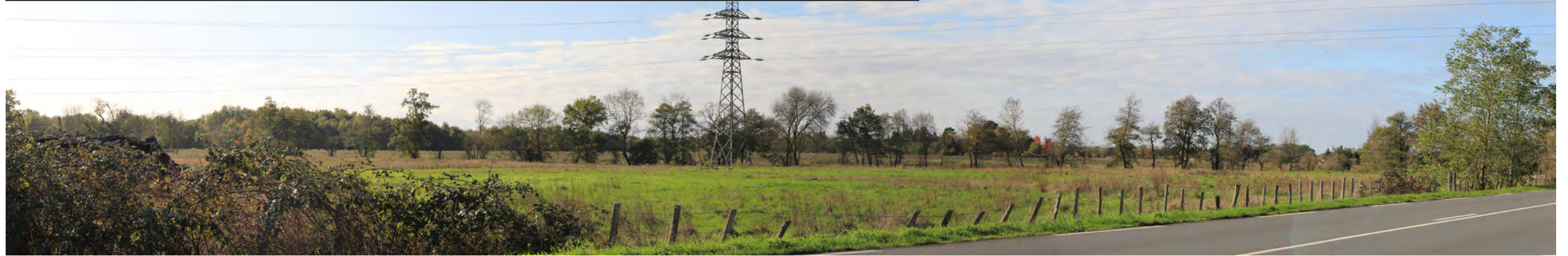
PM2 Etat actuel – Vue depuis la RD 6089, à proximité immédiate du poste électrique de transformation
